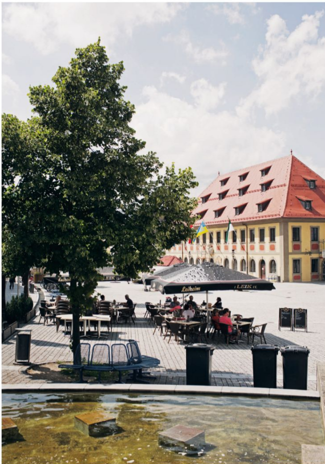
Das Rathaus von Lichtenfels wird gerade saniert, bekommt neue Elektrik, einen Fahrstuhl. Einen Modernisierungsschub erhofft sich auch die gesamte Stadt
